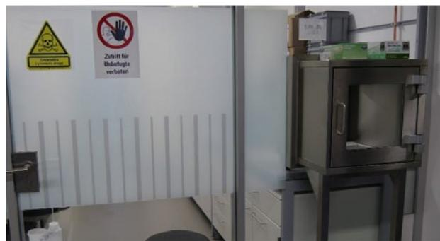
**Abb. 26:** Materialschleuse (rechts im Bild) zur gefahrungsfreien Ein- und Ausbringung von Material während laufender Arbeiten im Zytostatika-Raum
